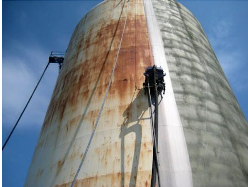
شکل ۶ ساب پاشی مخازن ذخیره مشتقات نفتی
